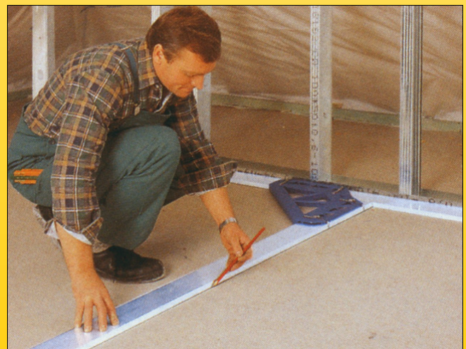
Wird eine der Latten durch den Winkel geschoben, erhält man einen T-Winkel.
