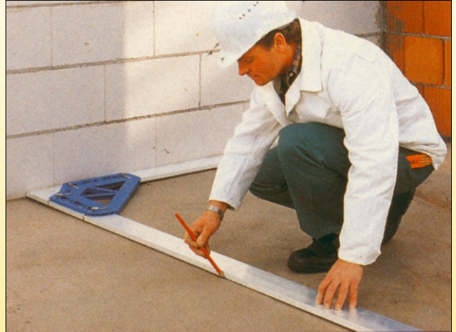
Mit dem PROFIX - Bauwinkel ist ein einfaches Anlegen und Anreißen eines rechten Winkels möglich.
