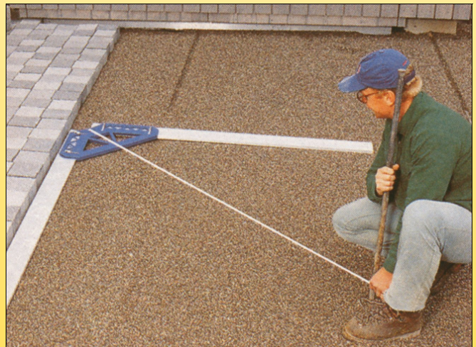
Mittels einer Maurer- oder Schlagschnur und der Winkelskala auf dem Bauwinkel lassen sich auch Winkel zwischen 0° und 90° problemlos konstruieren.
